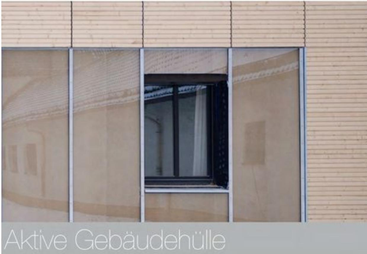
Fassadensystem für die energetische Sanierung
