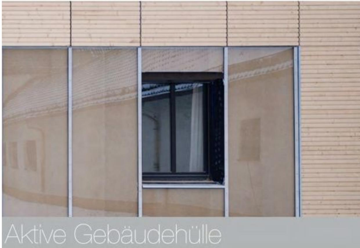
Fassadensystem für die energetische Sanierung
