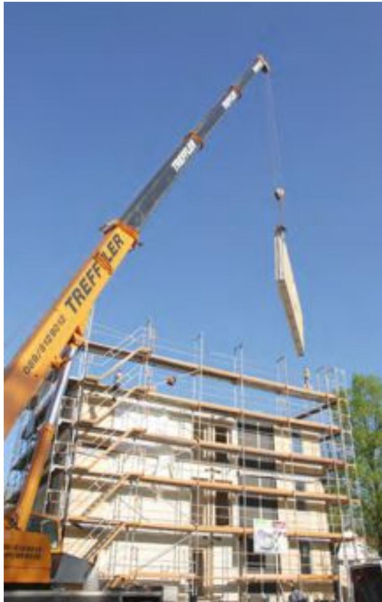
Wandelemente mit fertigen Fassaden, eingebauten Fenstern
